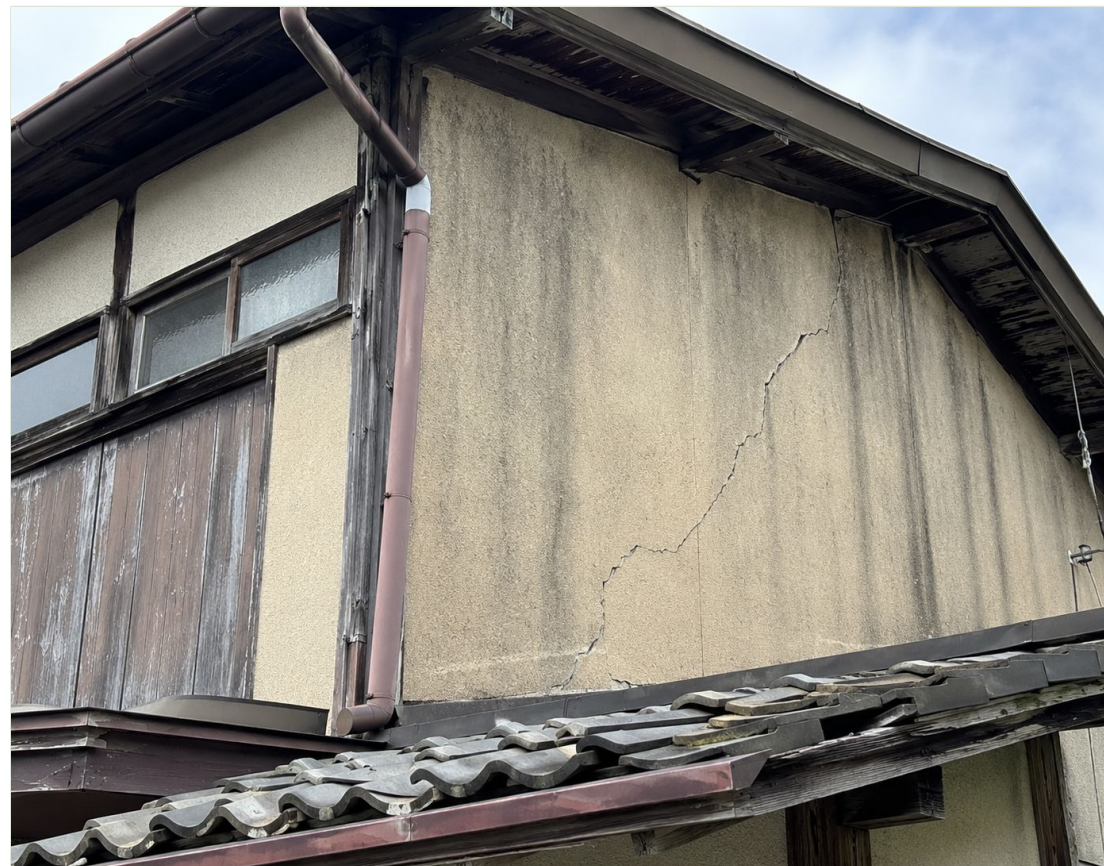
外壁と屋根: ひび・汚れ・屋根材のずれなど傷みが出やすい箇所を記録します。
