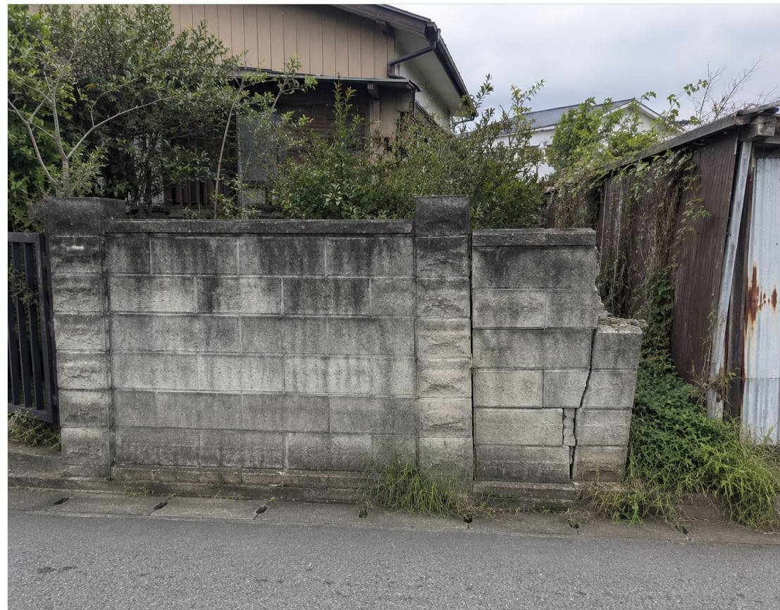
建物まわり: ブロック塀や物置など、付帯する工作物の状態を記録します。
